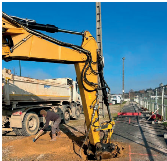
Début le 30 janvier au stade du percement pour l'ancrage des poteaux de l'ombrière.
