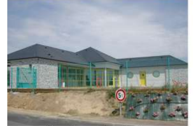
Construction de la maison de l'enfance-2006
