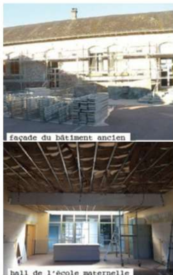
Réfection cour et école maternelle-2013
