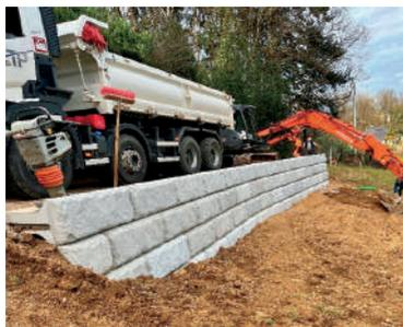
*La route du Moulin haut renforcée par un mur de soutènement neuf.*
