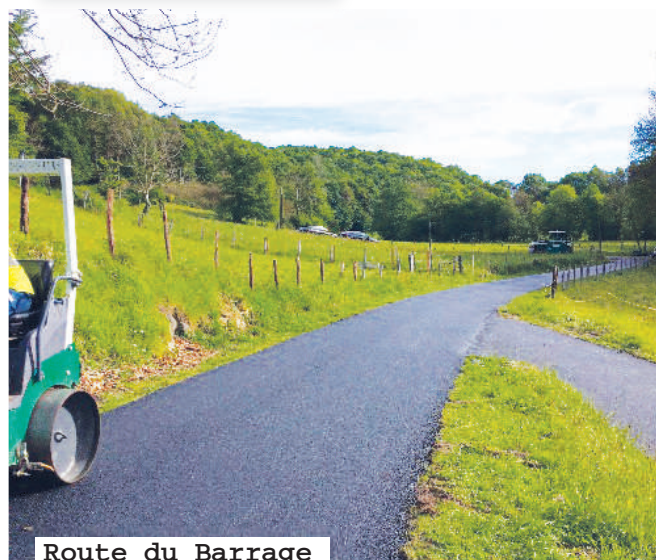
Route du Barrage
