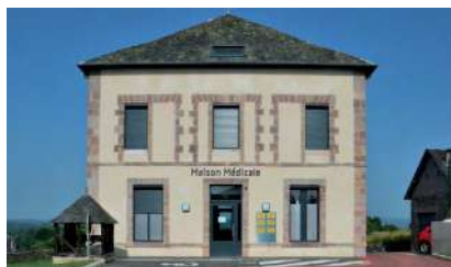
Entrée de la maison médicale côté parking
