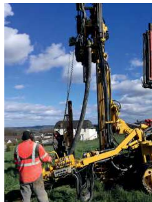
Forage test à 110m de profondeur
