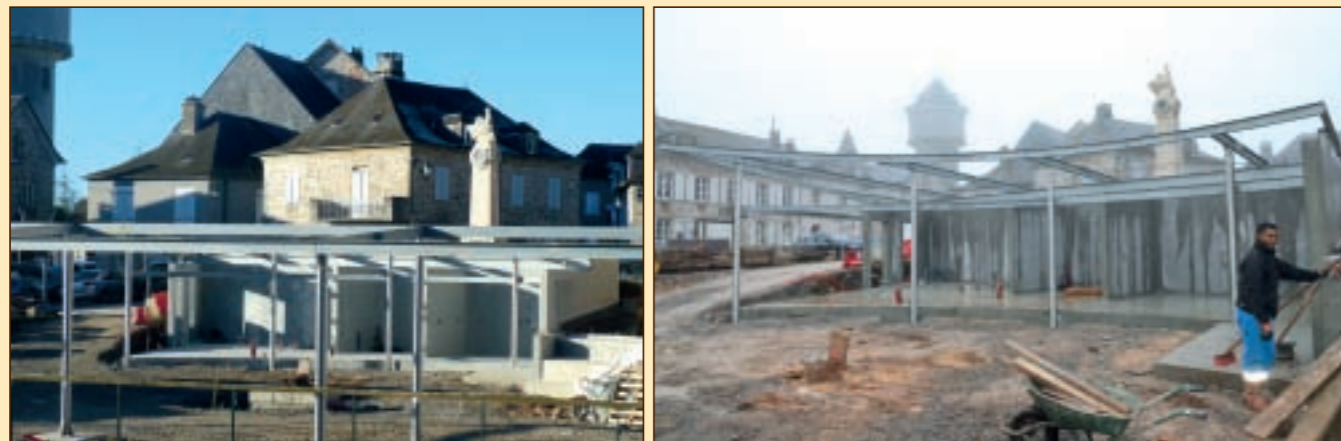
Ces travaux ont été coordonnés par MM. Mordrel, architecte, et Brisseau, de la société Colibris.
